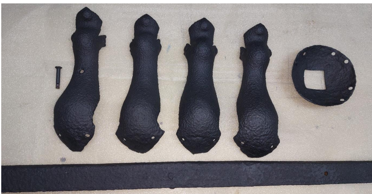
Stav komponentov fiály po nastriekaní farbou.
