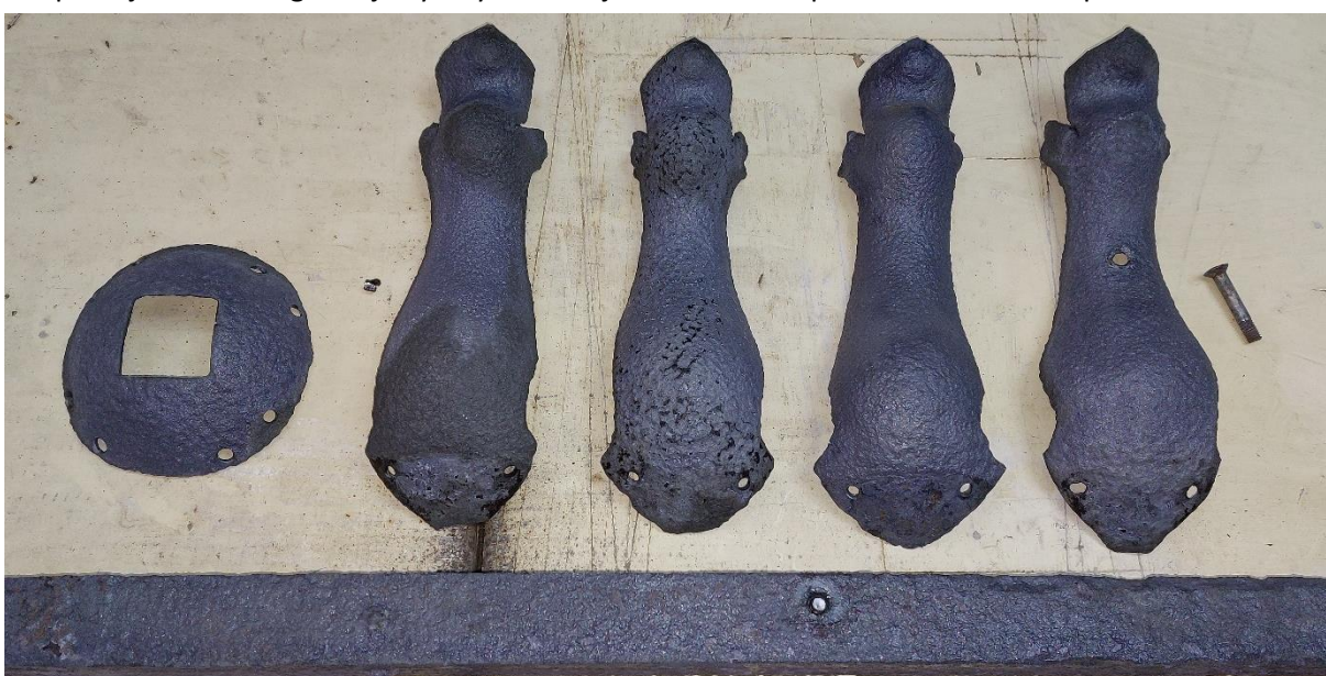
Roznitovanie a zakonzervovanie komponentov fiály
