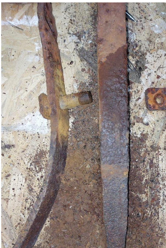
Poškodenia kovotlače a kotviacej konštrukcie kríža a fiály.
