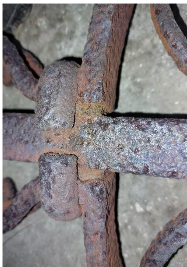
Poškodenia kríža spôsobené koróziou materiálu.
