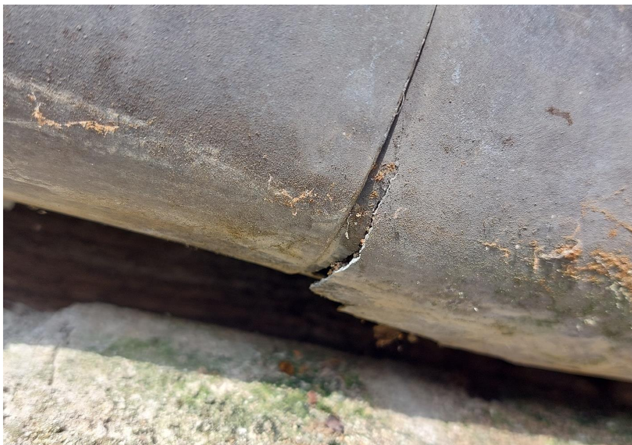
Skrehnutý a poškodený zinkový materiál.
