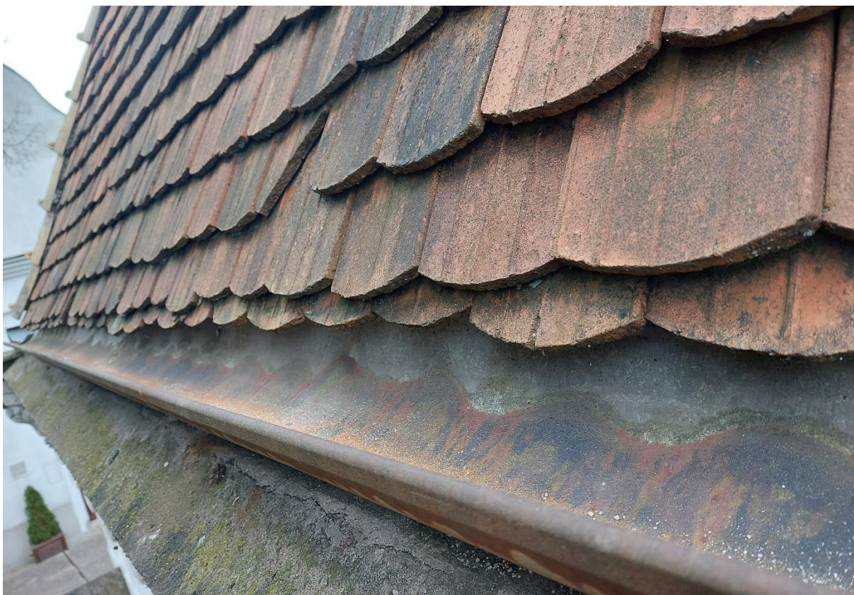
Nasadenie dočasného sekundárneho žlabu po demontáži hákov.
