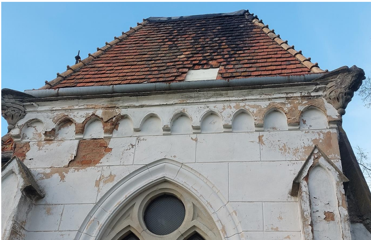
Stav po demontáži žlabových hákov východná strana
