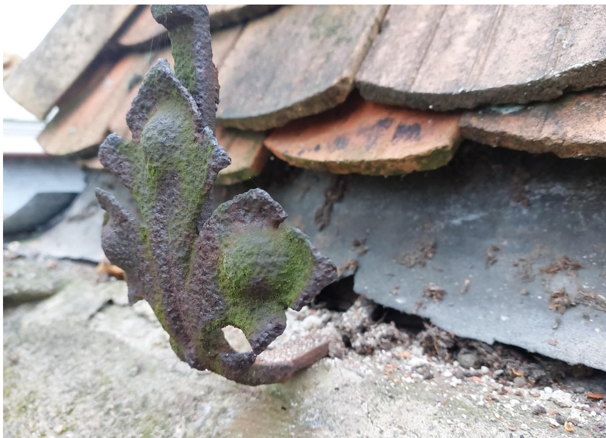
Stav po odstránení sekundárnych žľabov
