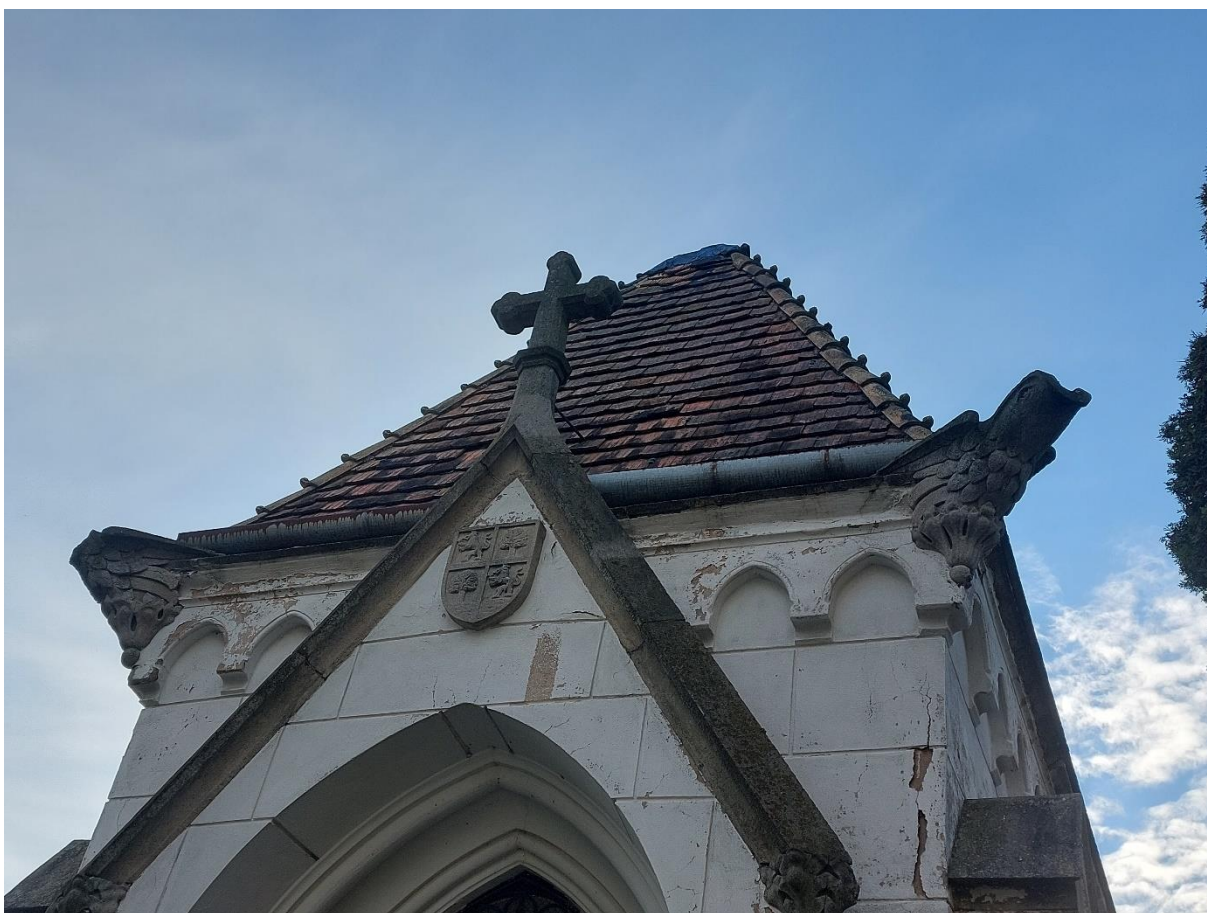
Stav po demontáži hákov predná strana.
