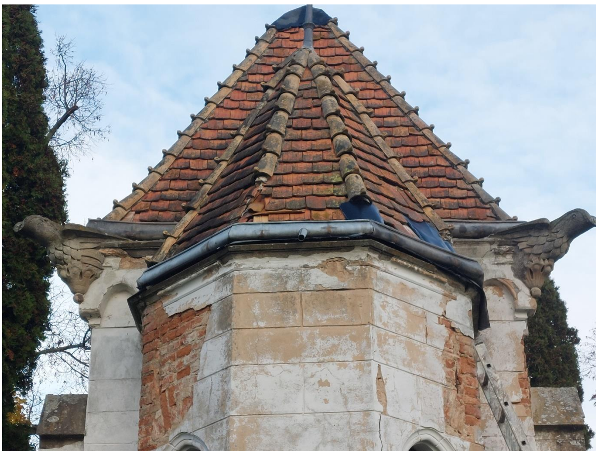
Demontáž rín hákov z apsidovej časti strechy
