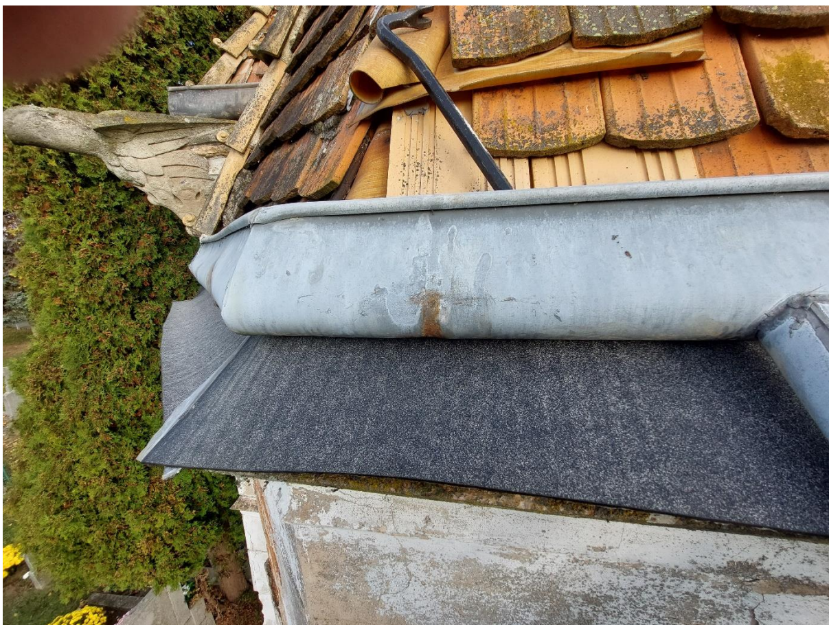
Podloženie bitúmenovej lepenky pod deravé žľaby. Lepenky boli podstrčené pod žľaby bez lepenia na originálnu kamennú hmotu.
