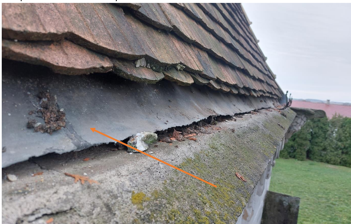
Stav po demontovaní hákov. Na fotografii vidno originálny fragment žľabu zo zinkového materiálu
