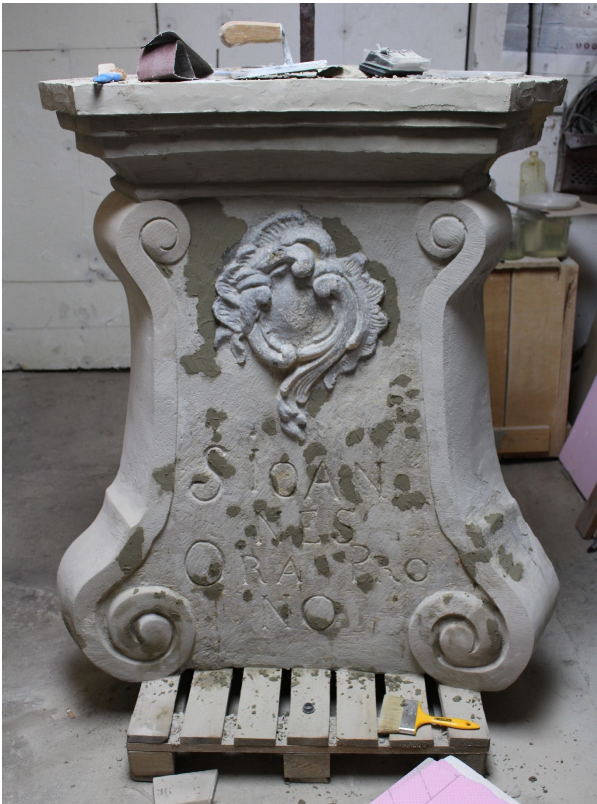
Celoplošné očistenie ornamentu rokaja a doplňujúce tmelenie drobných výpadkov kamennej hmoty
