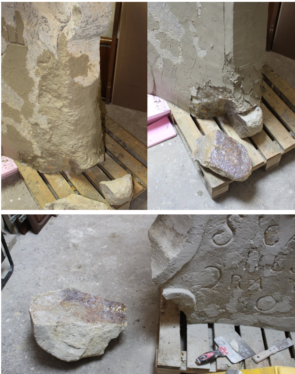
Lepenie fragmentov kamennej hmoty dvojzložkovým epoxidovým lepidlom
