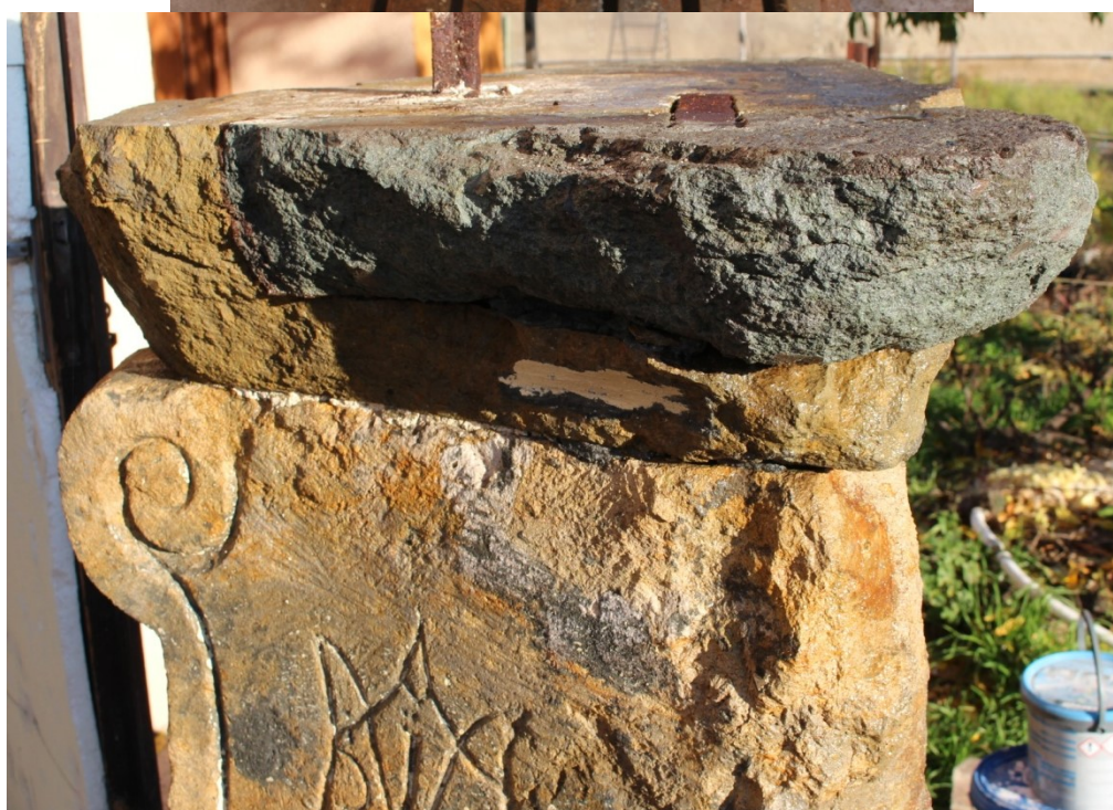
Opakovaná petrifikácia roztokom KSE 100 a následne po technologickej prestávke napustenie kamennej hmoty KSE 300 od firmy Remers.
