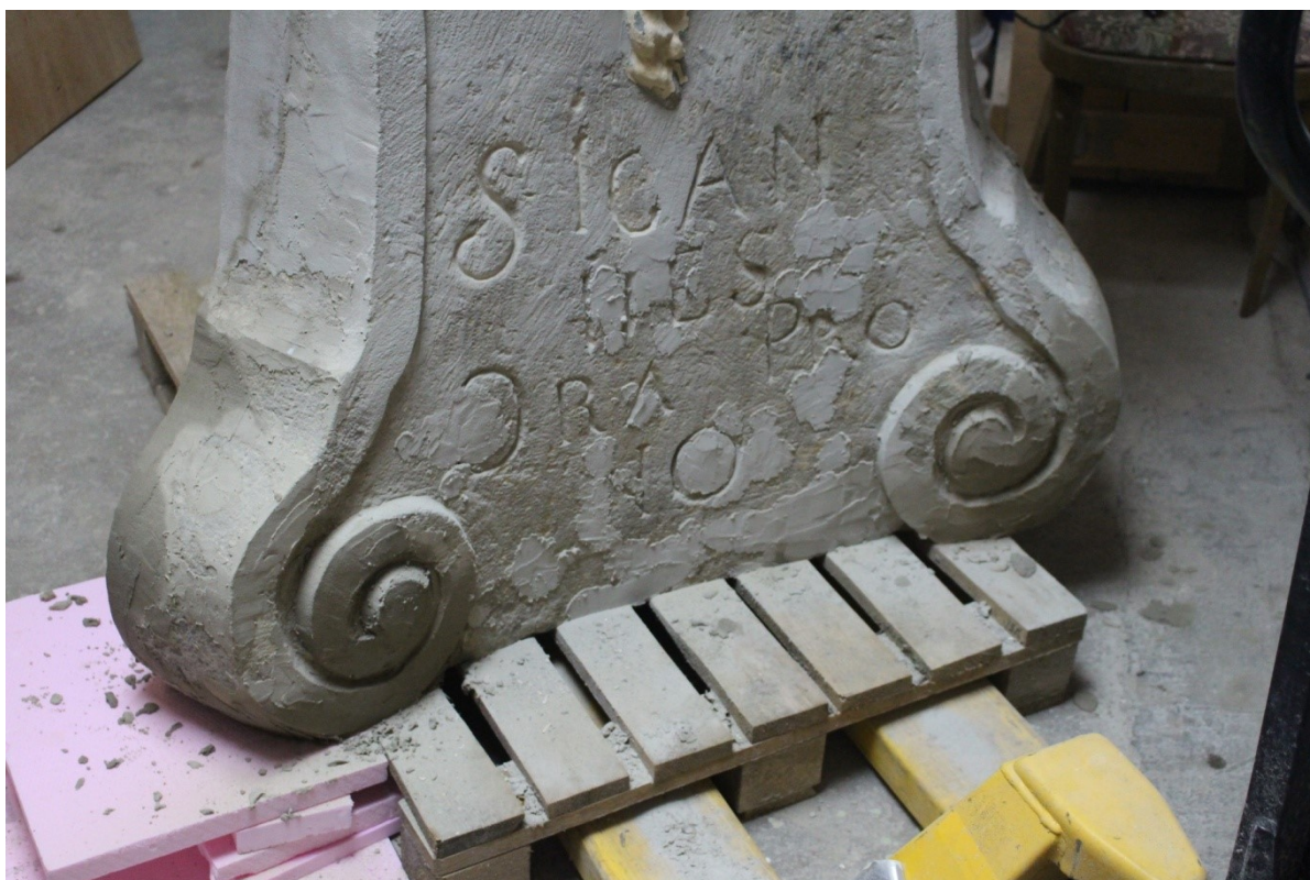
Tmelenie podstawca mineralnymi tmelami od firmy Remers
