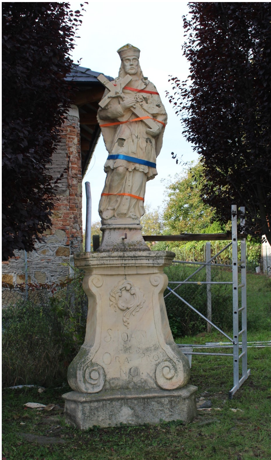
Zabezpečenie sochy pred demontážou
