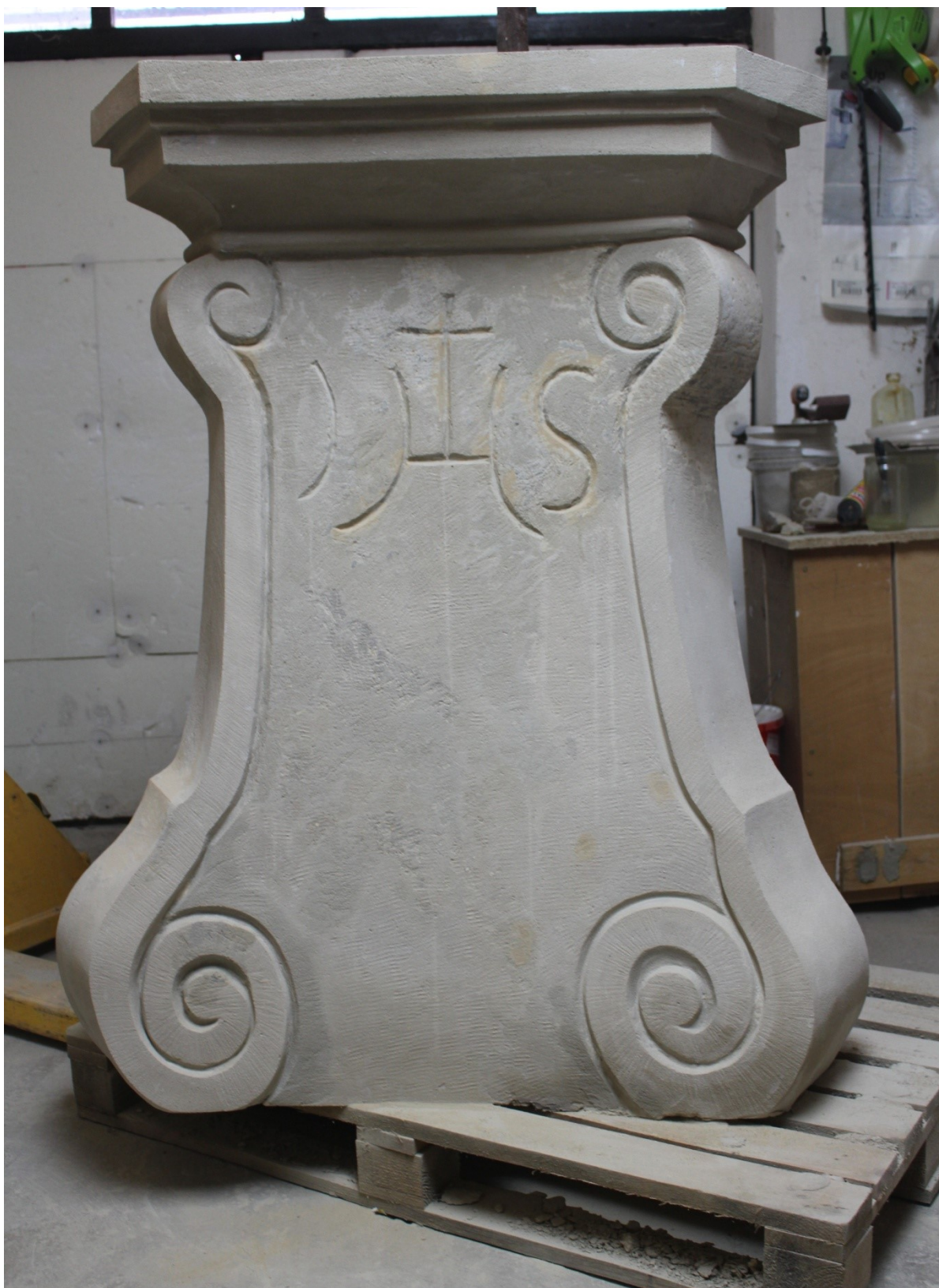
Stav po prebrúsení a premodelovaní minerálnych tmelov ( ľavá strana )
