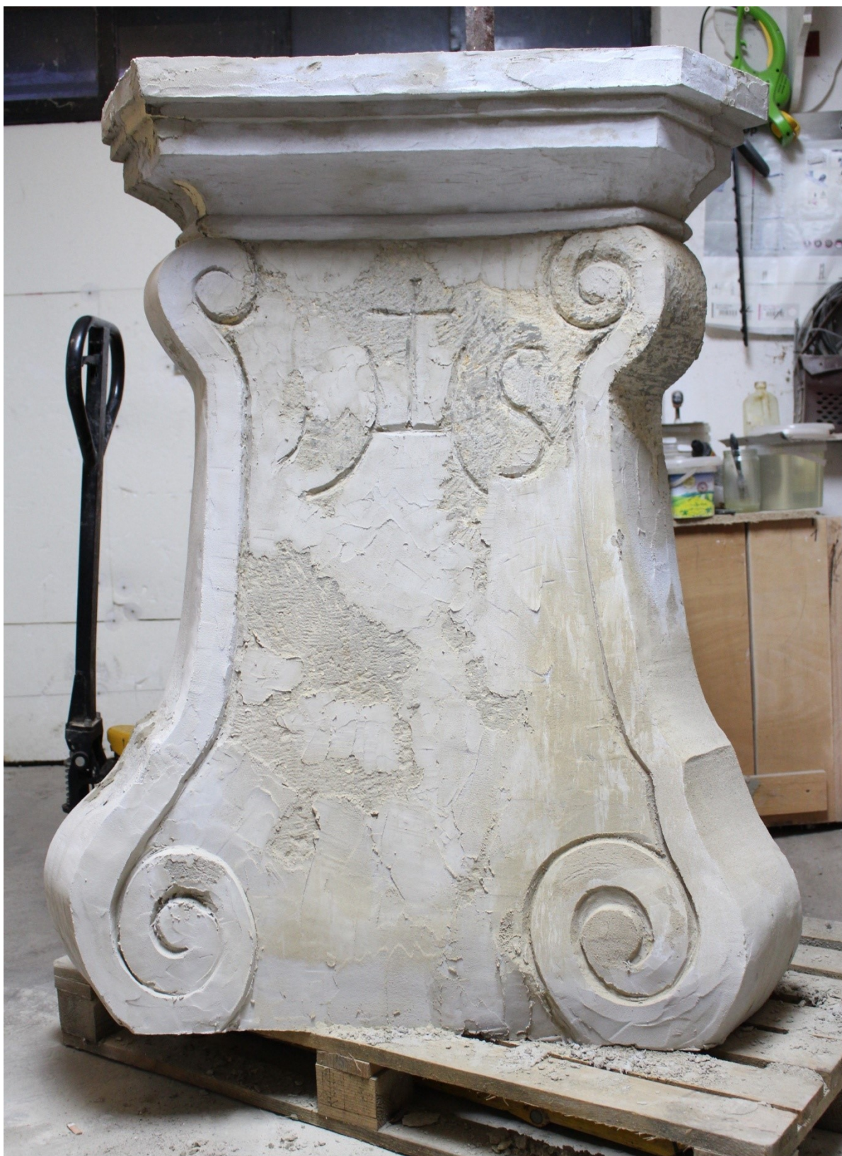
Stav podstavca po naložení minerálních zmesí ( ľavá strana )
