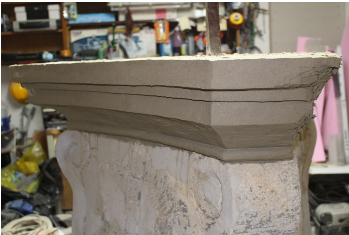
Vytvorenie profilácie hlavice minerálnymi tmeli
